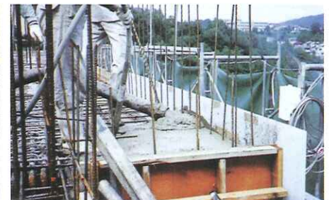
〈作業3〉コンクリート打設作業。
