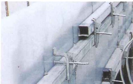
〈作業4〉コンクリート充填具合が陰影として見えます。
