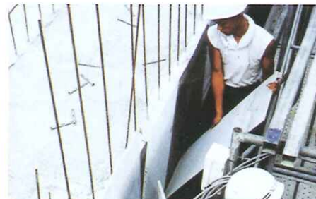
〈作業4〉コンクリート充填具合が陰影として見えます。
