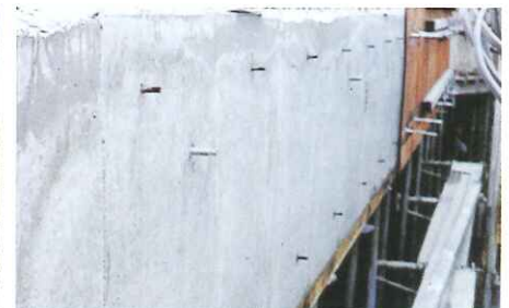
〈作業6〉綺麗な打設表面に仕上がります。
